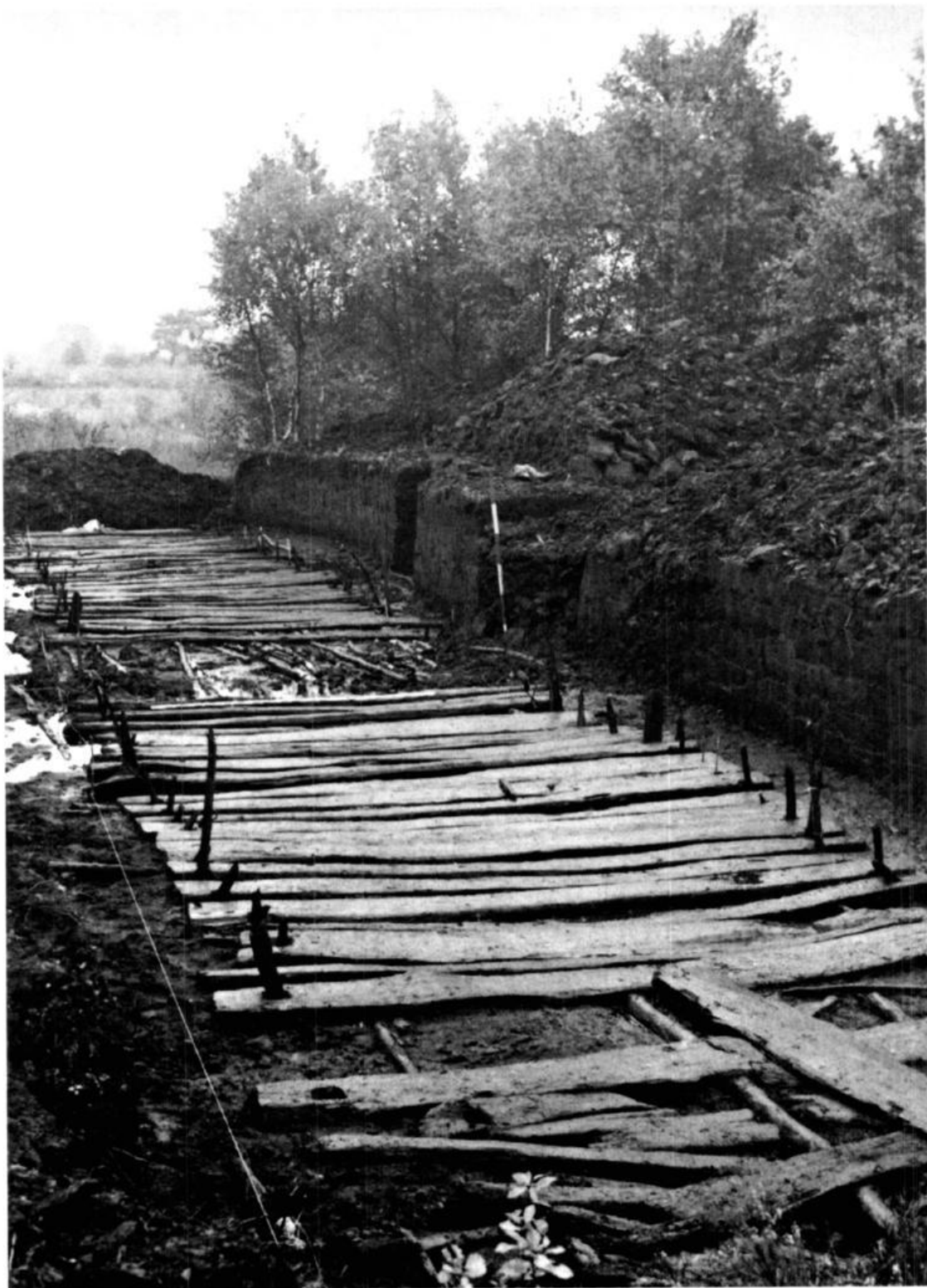
Abb. 6 - Fundstelle 6 - Der befahrbare Bohlenweg/Pfahlweg XLII (Ip) -42- Ausgrabung 1965 im Wittemoor bei Hude. Die Fernrichtung nach Norden weist auf die Hunte hin. Im Südbereich des etwa 3 km langen Weges waren in der Fahrbahn Eichenbohlen erster Wahl verbaut worden. Foto: H. Hayen
