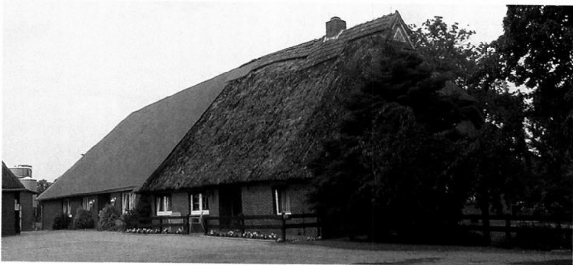
Die Bau Nr.21 in Oberhausen-Arnererethorpe, der „Schelgenhof“, im jetzigen Zustand (vgl. auch die Abb. auf der Titelseite).
