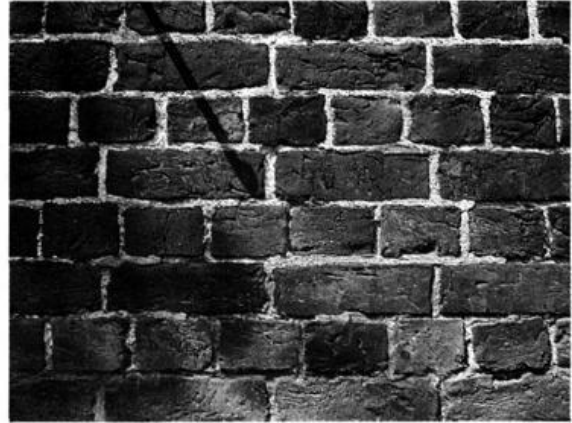
o.r.: Auf dem Sockel (etwa bis Bildmitte), den unser Vorfahr Hinrich Schelye 1691 für den hölzernen Turm gemauert hatte, setzte man später den jetzigen steinernen Turm.
