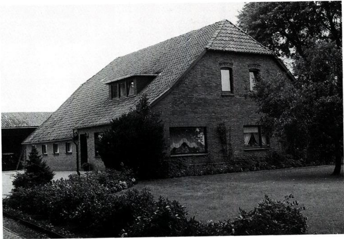
Abb. 12: Hofstelle des Ernst Oeltjenbruns am Wiesenweg in Kleefeld. 1907 wurde diese Parzelle zugewiesen, 1918 das Haus auf einem von Torf befreiten Sandrücken gebaut.
