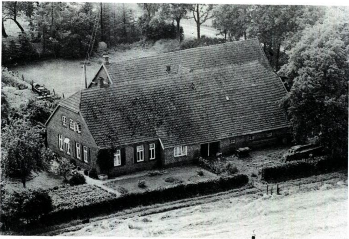
Abb. 14: Brinksitzerei Fritz Oeltjenbruns in Neuenkrüge, Zwischenahner Damm.
