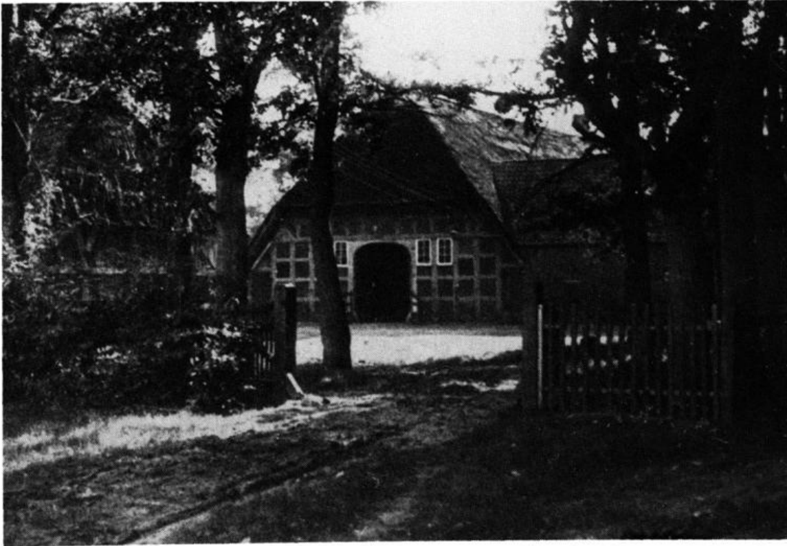
Abb. 11: Ehemalige Brinksitzerei Wübbenhorst in Hude, Vielstedter Kirchweg 21. Stammhaus des Wübbenhorst-Stammes Hude 2, begründet 1676 von Heinke Wübbenhorst (Hude 2 V.a), bis 1827 vier Generationen hindurch in Wübbenhorstschem Besitz; heutiger Eigentümer Heinrich Oetjen. Das Gebäude stammt aus dem Jahre 1819, als ein geräumigerer Neubau erfolgte.
