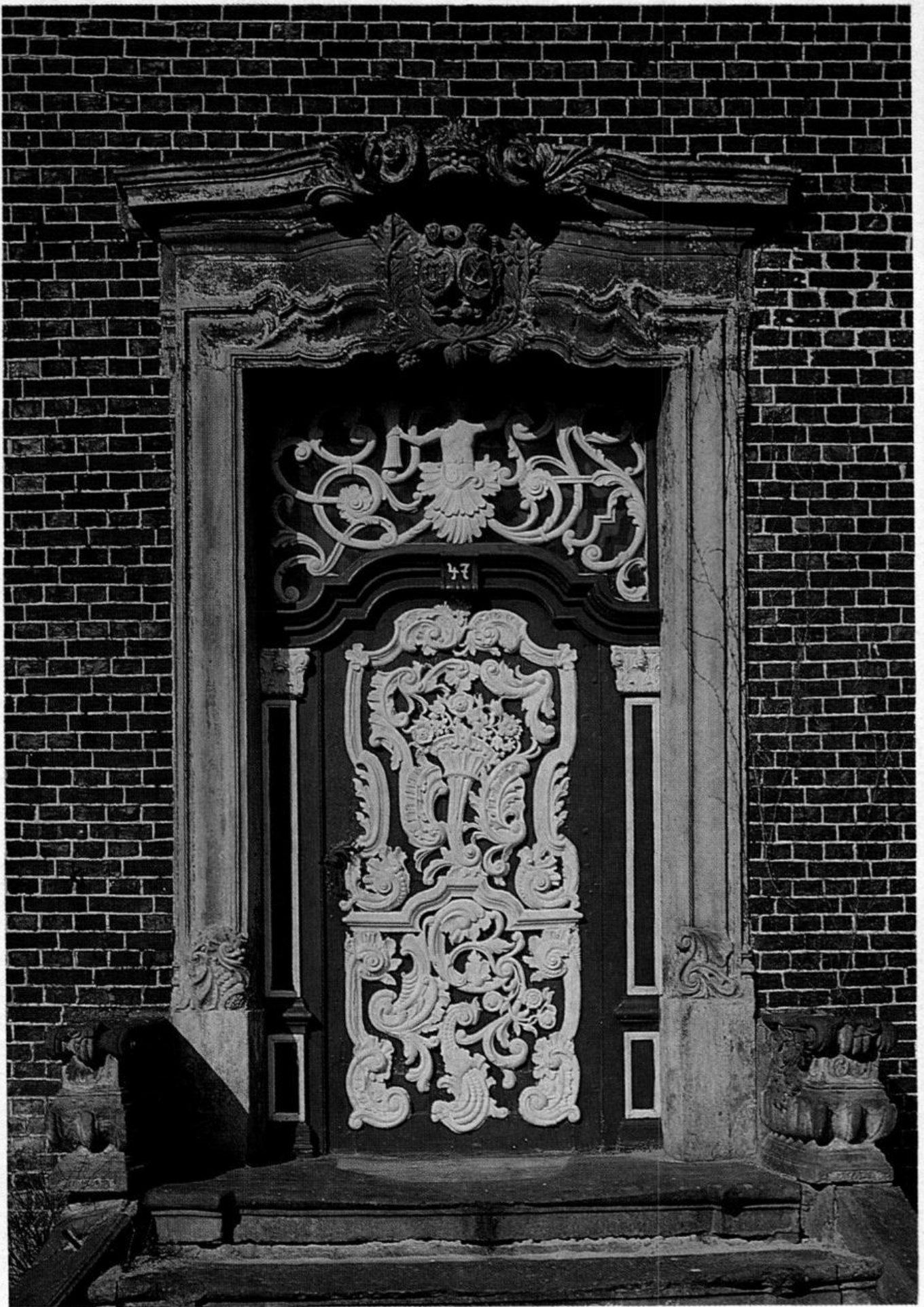
Abb. 7: Außentür des Kaufmannshauses Hemken in Bockhorn mit den Wappen Hemken und Bolcken (mit frendl. Genehmigung der Vereinigten Oldenburger Klinkerwerke, Bockhorn).
