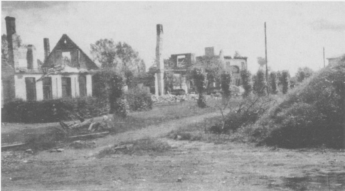
Abb. 6: Das zerstörte Friesoythe im Umfeld des heutigen Hansaplatzes; alle Häuser an der zur Mittelschule führenden Straße sind zerstört. Das Mittelschulgebäude ist ausgebrannt.
