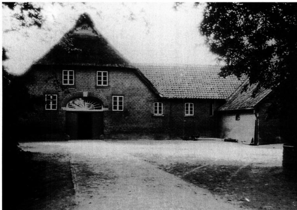
Abb. 16: Die Hausmannsstelle Marken in Ohrwege um 1925. Das neue Haupthaus wurde 1863 von Renke Marken, 1832-1873 (s. XII.7.), erbaut (vorher Fachwerkbau). Am Ende des II. Weltkrieges brannten die Hofgebäude einschließlich aller Stallungen und Nebengebäude (auf dem Bild nicht zu sehen) vollständig ab (außer das zum Hof gehörende Heuerhaus in Ohrwegerfeld).
