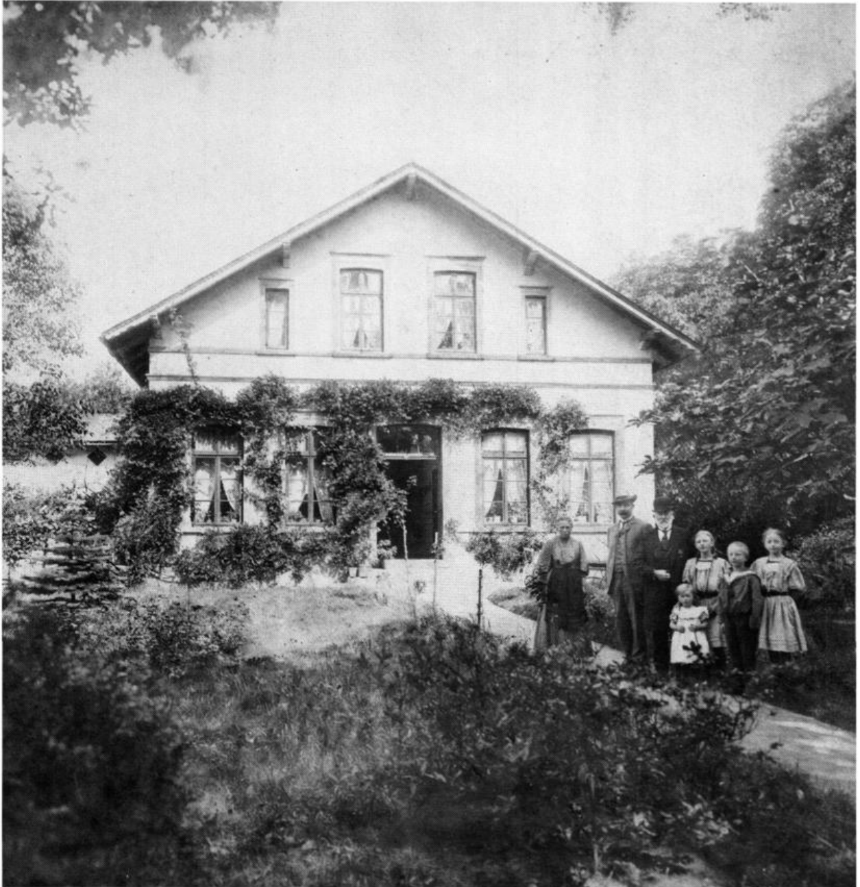
Abb. 26: Das Gemeindebüro, zugleich Standesamt, war das Verwaltungszentrum der Gemeinde Ohmstede. In über 60jähriger Amtszeit (1872-1933) wirkten Diedrich und Friedrich Hanken hier als Gemeindevorsteher, in einer Ära großer Fortschritte, aber auch einschneidender Ereignisse (Erster Weltkrieg und Inflation). Aufnahme etwa 1910.
