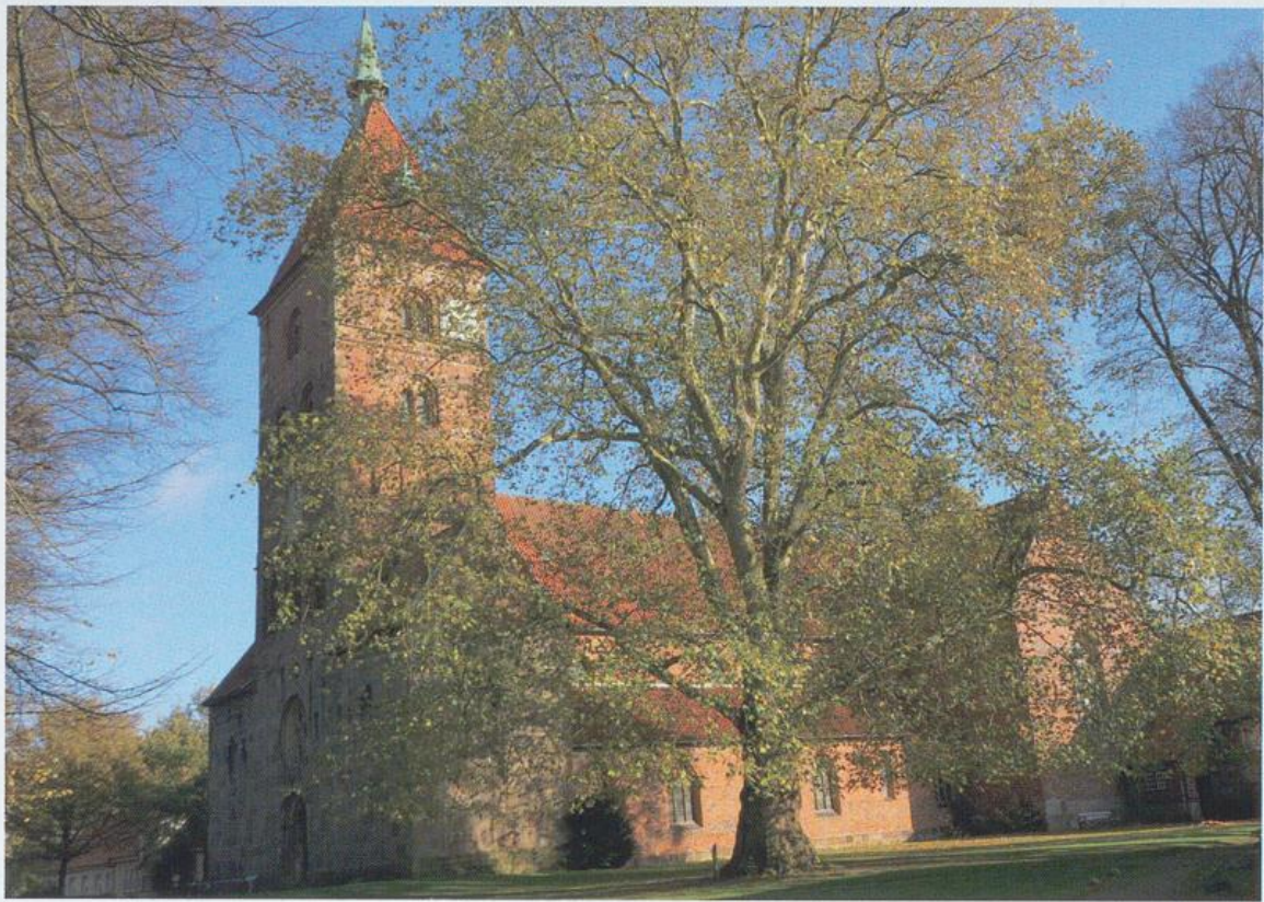
Abb. 3: Die Alexanderkirche, Blick von Südwesten
