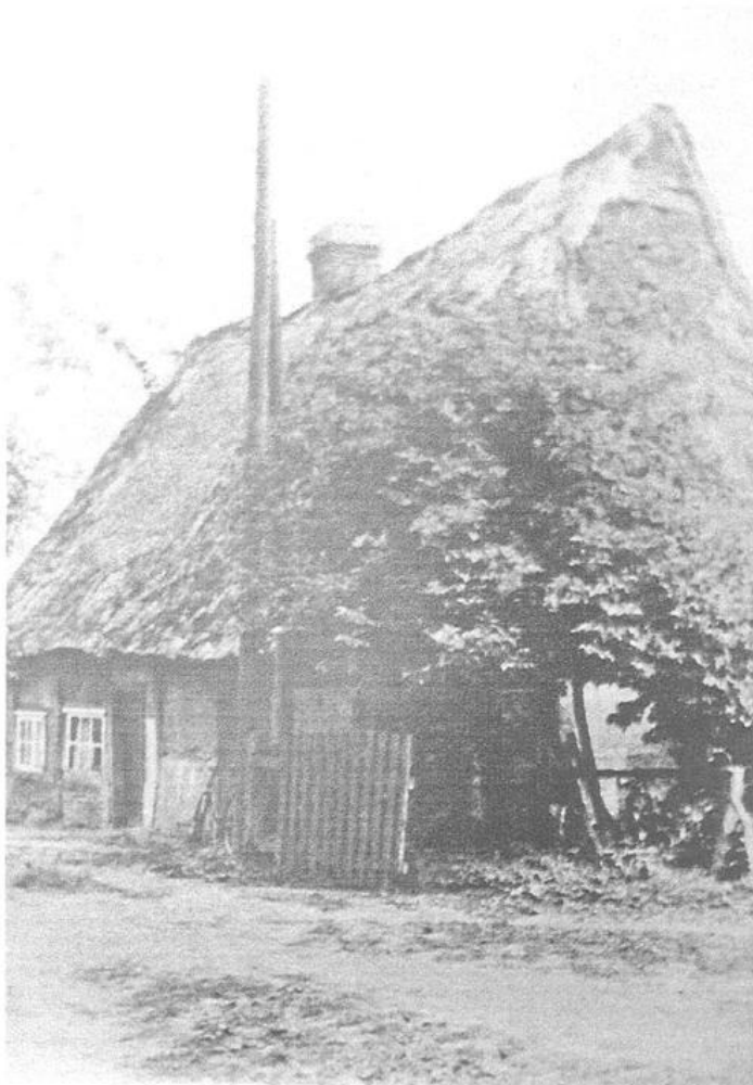
Abb. 2: Haus aus dem 18. Jahrhundert in der Burgstraße in Lastrup, das in der Bauweise mit weicher Bedachung, Walmdach, Fachwerk im Aussehen Häusern aus dem 17. Jahrhundert nahe kommt. Der Schornstein ist eine „moderne“ Hinzufügung, denn im 17. Jahrhundert gab es in den so genannten Rauchhäusern noch keine Schornsteine, geschweige denn eine sanitäre und hygienefreundliche Ausstattung. Der Lichtmast verweist auf die Einführung der Elektrizität in Lastrup (um 1910). Die Straße ist noch nicht gepflastert. Das Haus, das zuletzt von einer Frau
