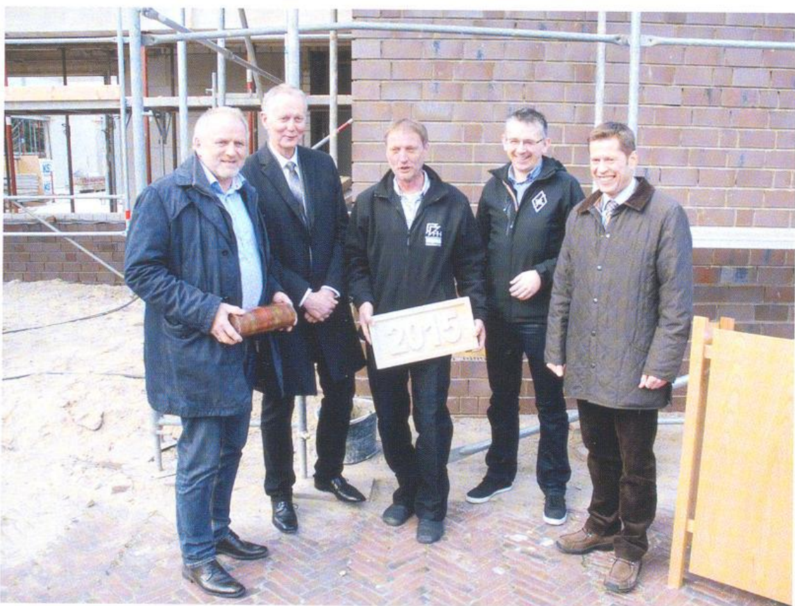
Bild 15: Ein Grundstein und ein Zylinder mit Urkunde und Tageszeitungen wurden anlässlich der Grundsteinlegung für die neue Turnhalle und die Mensa am 24.03.2015 in das Mauerwerk der Turnhalle eingelassen: (v.l.) Werner Dröge (db-Bau; Planungsunternehmen für das Objekt), Johannes Fortmann (Vorsitzender des Vereins „Bürger für Löningen“), Manfred Thien (vom ausführenden Bauunternehmen Hillenhinrichs), Stefan Beumker (1. Vorsitzender VfL Löningen), Marcus Willen (Bürgermeister Stadt Löningen)
