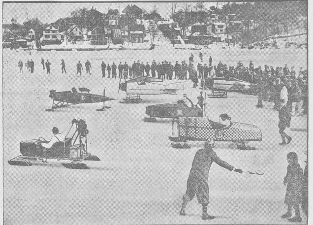
(Start zur Propellerschlitten-Wettfahrt auf der Worcester-Eisbahn (Amerika). — Die neueste Erfindung des amerikanischen Winterports ist der Propellerschlitten, mit dem sich außerordentlich schnelle Fahrten auf ebener Fläche ausführen lassen. In der Form ähnelt der Propellerschlitten einem flügellosen Flugzeug, er ist mit Rufen ausgerüstet und der Propeller wird durch einen eingebauten Motorrad-Motor getrieben. Eine Stundengeschwindigkeit von 95 Kilometer kann leicht erreicht werden.
