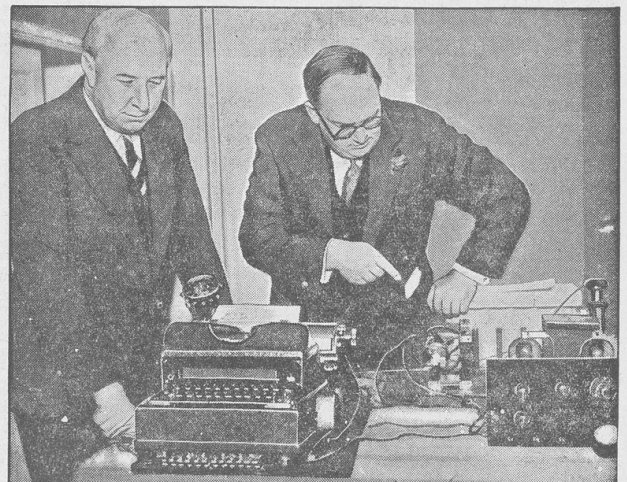
Der Erfinder des Kurzwellenschreibers G. R. Watson-Detroit vor seiner Apparatur, genannt „Watsongraph“. In Detroit (USA.) wurde die erste Kurzwellen-Fernschreibmaschine vorgeführt, die aus beliebiger Entfernung bedient werden und 200 Buchstaben in der Minute schreiben kann. Zur Verhinderung eines unbefugten Empfangs der Sendungen wurde die Maschine mit einer außerordentlich komplizierten Chiffrier- und Dechiffrier-Vorrichtung versehen.
