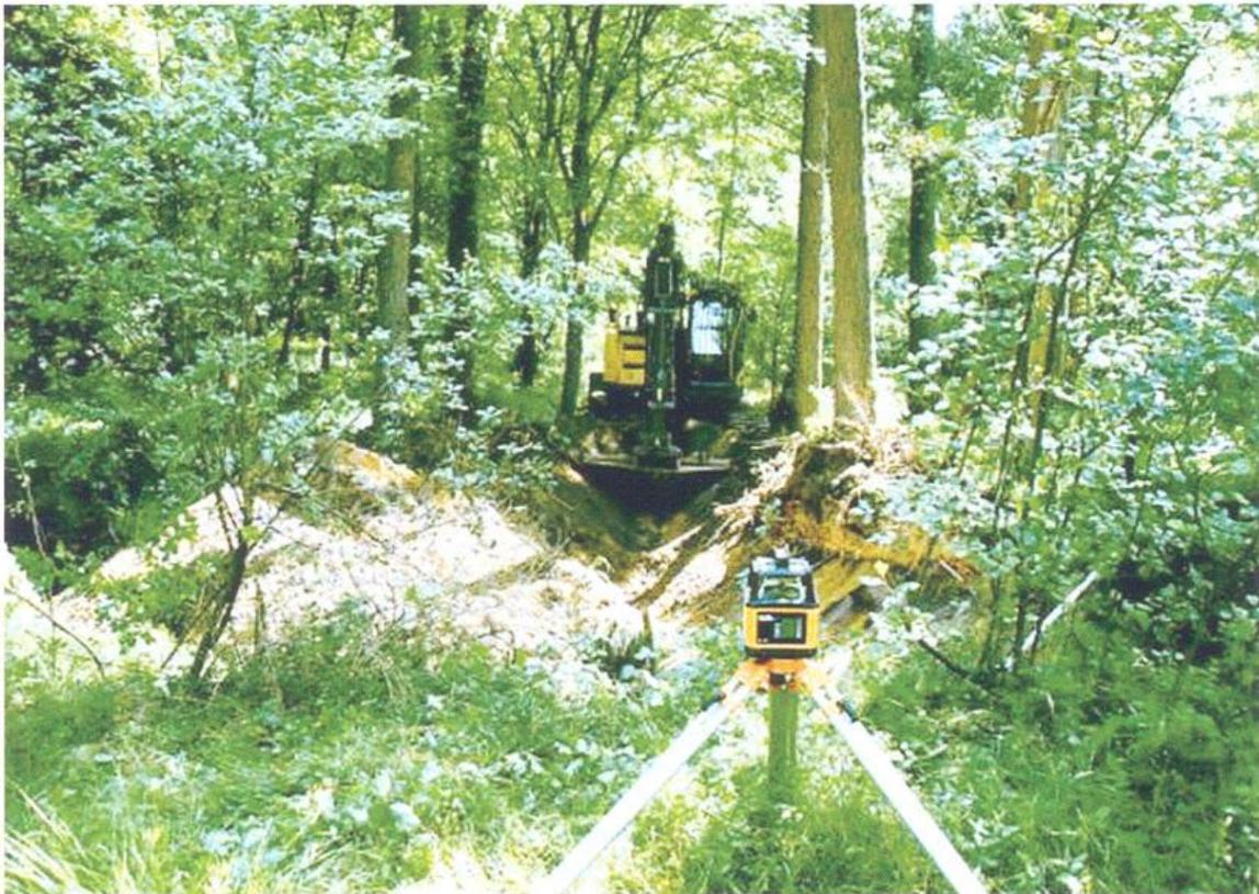
*Abb. 7: Nivellierung der Poolfläche und Dränagerückbau*
