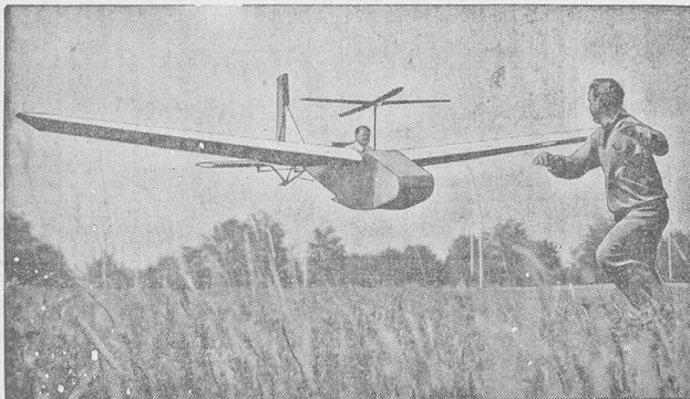
(Das Windmühlen-Segelflugzeug während des Probeflugs. — Im Vordergrund der Erbauer, Segelflieger Hans Richter.) — Der erfolgreiche Segelflieger Hans Richter hat jetzt ein neuartiges Segelflugzeug konstruiert, bei dem sich über den Tragboden eine vierflügelige Schraube befindet, die durch den Wind angetrieben wird und dem motorlosen Flug eine größere Sicherheit verleihen soll. Der erste Versuchflug verlief zur Zufriedenheit des Erbauers.
