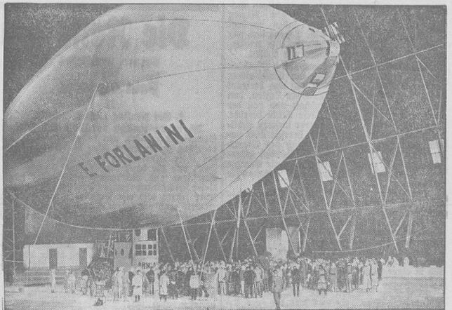
Das neue italienische Kleinluftschiff. — In Mailand wurde ein von dem Ingenieur Forlanini konstruiertes Luftschiff hergestellt, das ohne Hilfe von außen starten und landen soll. Die Motorenkräfte betragen nur 160 PS.
