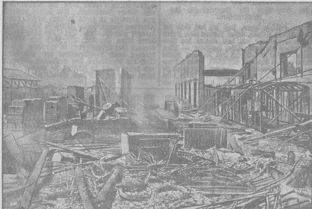
Der Genfer Grenzbahnhof niedergebrannt.
