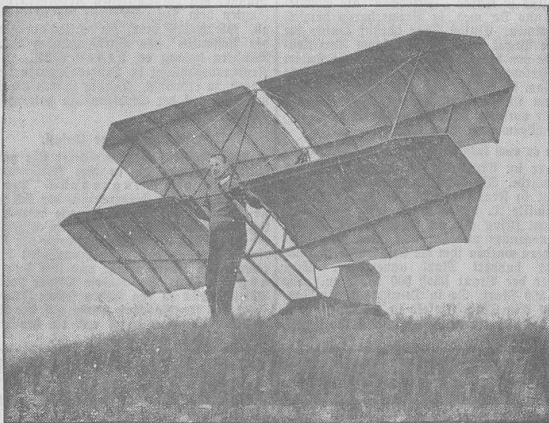
Der Berliner Segelflieger Hans Richter mit seinem neuen Gleitflugzeug, dessen Herstellungspreis sich auf 170 Reichsmark beläuft. Das Gewicht des Gleitflugzeugs beträgt 25 Pfund. Seine Spannweite etwa fünf Meter.
