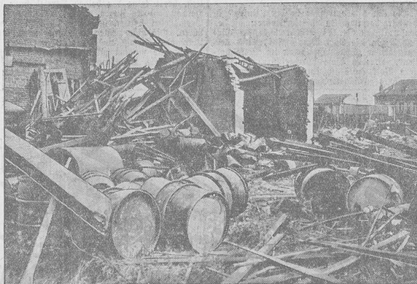
Die Trümmerstätte der chemischen Fabrik in Becons. — In Becons in der Nähe von Paris explodierte aus unbekanntem Gründen eine chemische Fabrik. Vier Tote und zahlreiche Schwerverletzte wurden aus den Trümmern geborgen.
