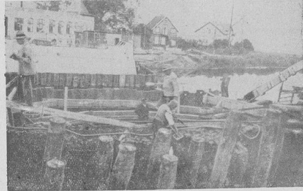
Unsere Bilder geben Einblick in den Betrieb beim Bau der neuen Brücke über den Ems-Jade-Kanal in Mariensiel. Die erste Pfeiler-Grube hat inzwischen die Betonfüllung aufgenommen. Da die Grundpfeiler somit fertiggestellt sind, geht man jetzt daran, die Brückenträger über den Kanal von Fundament zu Fundament zu verlegen. Auf der nebenan liegenden alten Brücke können tagtäglich zahlreiche Vorüberkommende dem Fortgang der interlanten Arbeiten zu.
