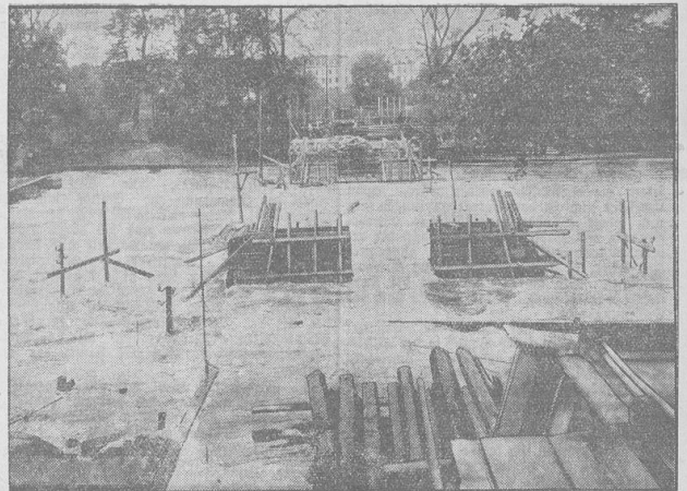
(Eine von den Fluten völlig zerstörte Betonbrücke in Rheine.) — Schiefen ist von den Hochwassern der Ober- und der Rheine, die durch das Unwetter der letzten Zeit verursacht wurden, schwer bedroht. In den Flußgebieten wurde schwerer Flußschaden angerichtet; in Rheine ist eine große, im Bau befindliche Betonbrücke durch die Fluten völlig eingerissen worden.
