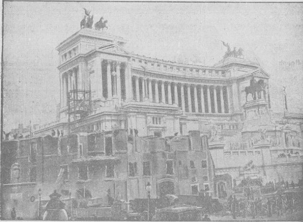
(Die Abrucharbeiten gegenüber dem gewaltigen Viktor-Emanuel-Denkmal.) — Zwischen dem Piazza Venezia und dem Colosseum in Rom soll eine große neue Straße gelegt werden, die durch den ständig größer werdenden Autoverkehr in der alten Kulturstadt dringend nötig geworden ist. Häuser, die Jahrhunderten getrotzt haben, müssen jetzt der Epitaphade weichen, um einer modernen Großstadtstraße Platz zu machen. Schon Ende des Monats wird der letzte Stein abgetragen sein.
