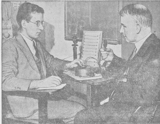
Der amerikanische Professor Gault demonstriert seinen neuen Apparat. — Prof. Gault von der Universität Chicago hat einen neuartigen Apparat konstruiert, mit dem Taube oder Schwerhörige die Sprache unmittelbar durch die Finger fühlen können. Der Sprecher hält ein kleines Mikrophon vor den Mund, durch das die Sprachtöne aufgenommen und so verstärkt werden, daß der Taube die Bewegung einer Membrane fühlen kann.
