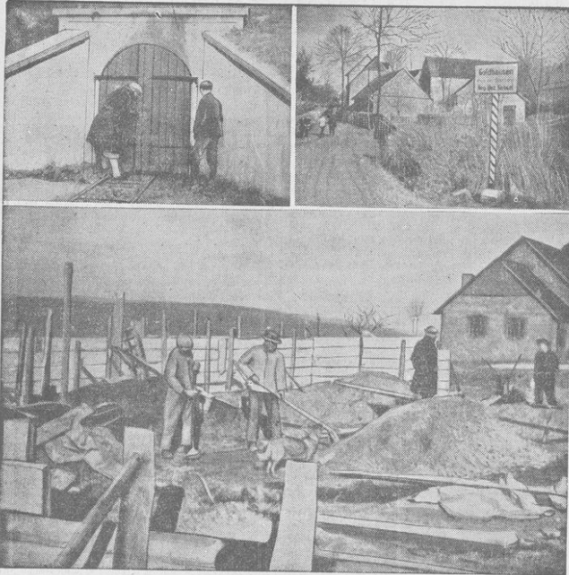
Oben links: Die Einfahrt zur Grube „Eisenberg“. — Oben rechts: Der Eingang zu dem Dorf Goldhauen. — Unten: Die Ausschüttungsarbeiten zur neuen Grube werden begonnen. — Die Bewohner des armen Dorfes Goldhauen im Regierungsbezirk Kassel sind durch eine große Senation überrascht worden. In den verlassenen Schächten der Grube „Eisenberg“ sind Goldadern entdeckt worden, deren Wert auf 21 Millionen Mark geschätzt wird. Der Abbau soll wieder aufgenommen werden und die Bewohner des Dorfes mit dem wiedereröffnenden Namen warten nun mit Spannung darauf, ob sich die Erwartungen erfüllen.
