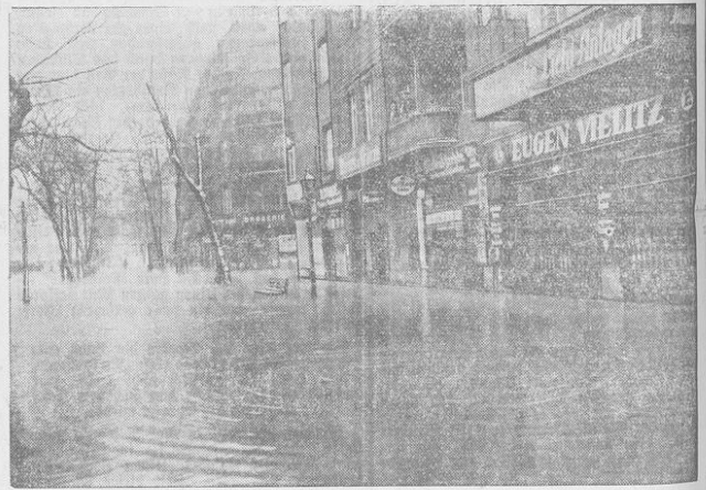
Der größte Wasserrohrbruch, den Berlin je erlebte.
