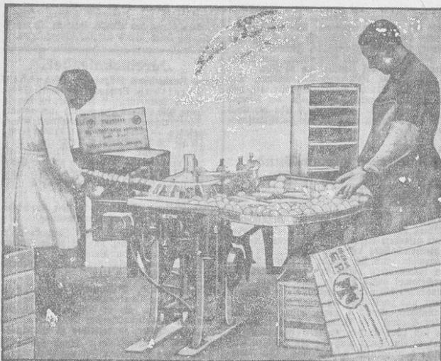
Die Sortiermaschine, die die durchgegangenen Eier (links) in einer Trommel aufnimmt und nach der Feststellung des Gewichtes wieder abgibt. Sie rollen automatisch in die voneinander getrennten fünf Fächer der S-, A-, B-, C- und D-Gruppe.
