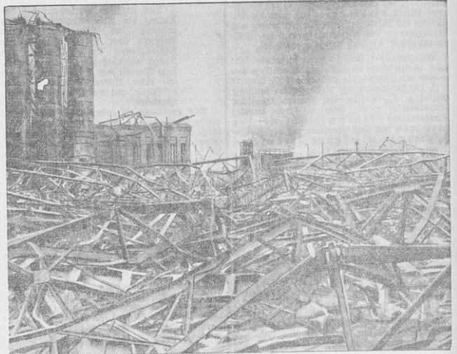
Das zusammengefügerte Eisengerippe des Gasometers.
