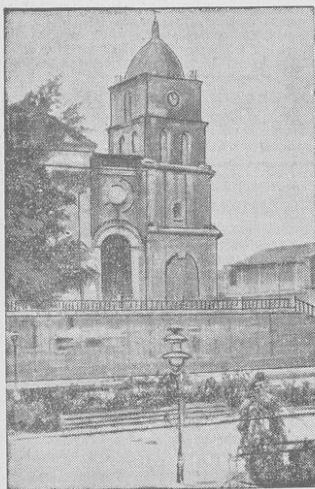
Dieses Bauwerk fiel dem Erdbeben auf Cuba zum Opfer.
