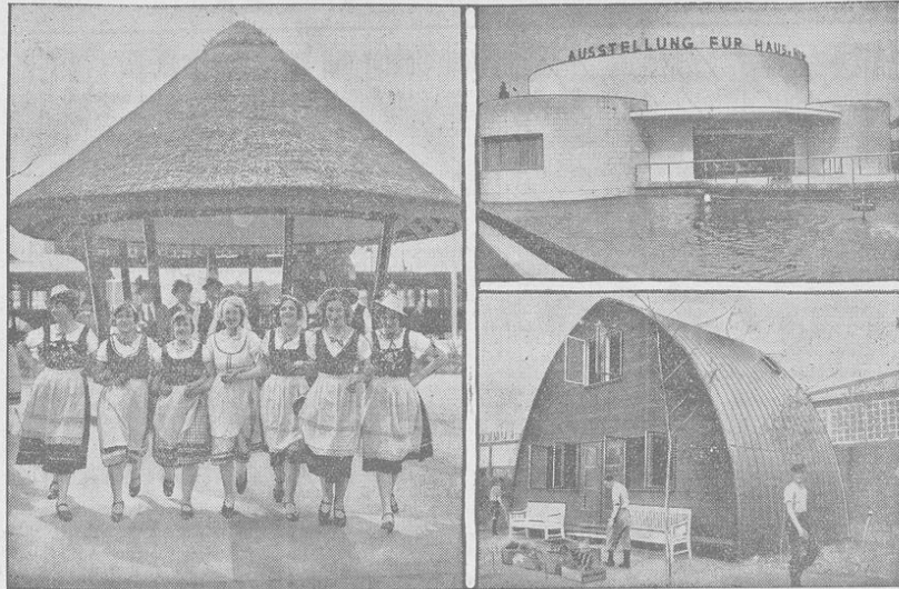
Links: Mädchen in Bauerntrachten geben den Ausstellungsstraßen ein fröhliches Gepräge. Rechts oben: „Das Haus am Wasser“, einer der Hauptanziehungspunkte der Ausstellung. Unten: Kleinfiedlungshaus mit eigenartiger Dachformung. — Auf dem Berliner Ausstellungsgelände wurde die reich besuchte Sommerchau eröffnet, die unter der schönen Parole steht: „Sonne, Luft und Haus für alle“.
