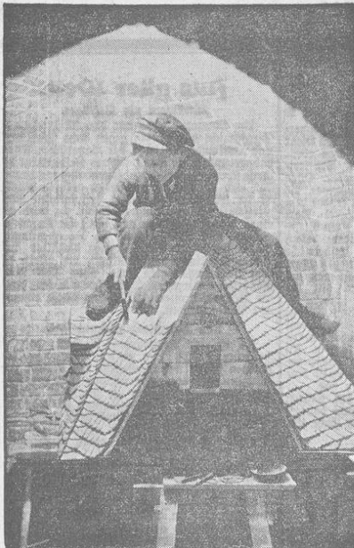
Es gibt verschiedene Anordnungen der Ziegel auf dem Dach. Der Dachdeckerlehrling bringt hier bei dem Miniaturdach schon verschiedene Arten an. Zum Schluss wird ausprobiert, welche Ziegelanordnung das Wasser besser ableitet und standhafter gegen die Witterung ist.
