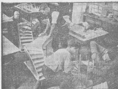
Nach vorgeschriebenen Maßen, die nachher in das Miniaturhaus passen, zimmern die Tischler die Treppe. Auch Neigungswinkel, Materialstärke und notwendige Tragfähigkeit sind genau angegeben.
