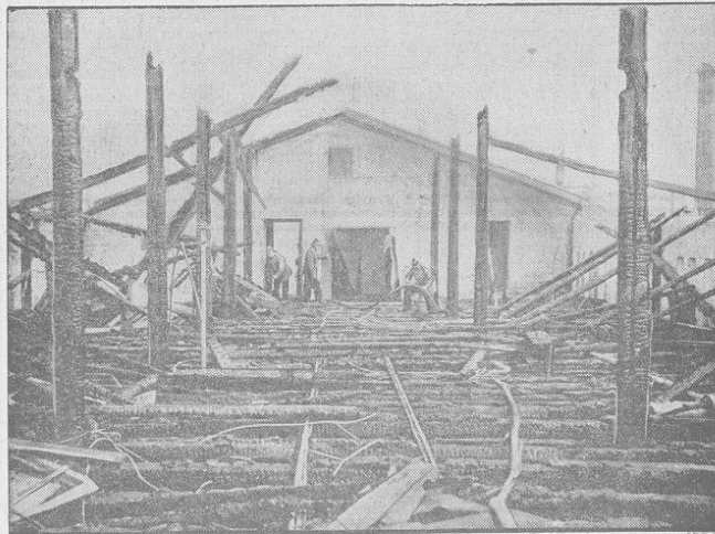
Blick in eines der ausgebrannten Fabrikgebäude. — In den Deutschen Industrie-Werken in Berlin-Spandau brach ein Großfeuer aus, das zu den größten Bränden gehört, die die Reichshauptstadt in den letzten Jahrzehnten erlebte. Trotzdem dreizehn Löschzüge eingriffen, wurden 10 000 Quadratmeter der Fabrikanlagen durch das Feuer völlig zerstört.
