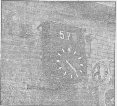
Elektrische Uhren: Oben: Bahnhofsuhr mit Stundenanzeiger und Sprungziffern für Minutenangabe. Unten: Moderne Synchrouhr mit Sechstontakt.
