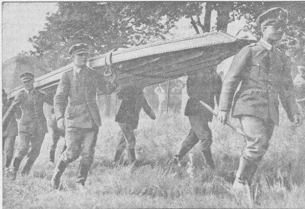
Reichswehrpioniere bei dem Transport des zusammenklappbaren Stahlbootes. — Bei den Pionierabteilungen der Reichswehr sind jetzt neue Ponton-Boote aus Stahl eingeführt worden, die zum bequemeren Transport ganz schmal zusammenklappbar sind.
