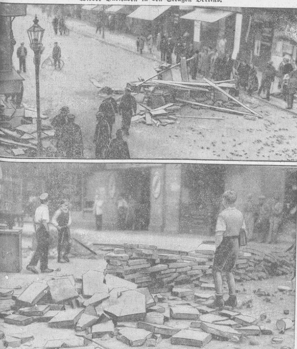
Barrikaden in Berlin-Moabit, die von Kommunisten aus Pflastersteinen, Brettern und anderen Gegenständen errichtet wurden, um die Durchfahrt der Polizeiwagen zu verhindern, die gegen verbotene Demonstrationen eingesetzt werden sollten. Starke Polizeikräfte mußten eingesetzt werden, bis die Ordnung wieder hergestellt war.
