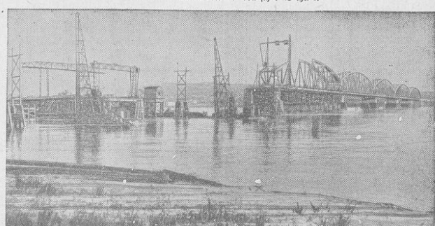
Die Donaubrücke bei Regensburg, die größte Brücke Europas, steht jetzt kurz vor der Vollendung. Die ganze Brücke ist über 1,5 Kilometer lang; die Boden- und Strömungsverhältnisse bedingten eine außergewöhnlich tiefe Fundierung der Trägerpfeiler.
