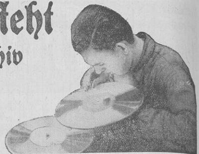
Platten werden mit der Lupe nach Fehlern abgeprüft.
