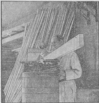
Die Rohhölzer, aus denen Schneeschuhe hergestellt werden sollen, wiegt der Schneeschuhmacher zuerst auf gleiches Gewicht genau ab. Die fertigen Bretter müssen abso- lut gleich schwer sein.
