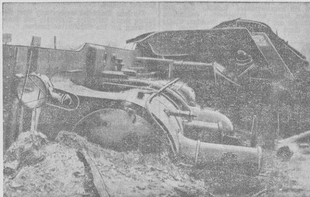
Die im Schlamm tief eingesunkene Lokomotive des französischen Schnellzuges, der bei Perpignan (nahe den Südbrenen) infolge Unterfüllung des Bahndammes entgleiste. Sieben Passagiere wurden getötet und viele, darunter mehrere Deutsche, verletzt.
