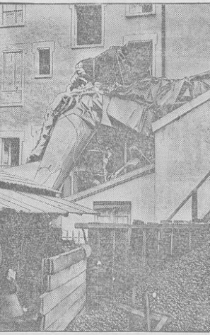
Flugzeug fliegt in Hauswand.
