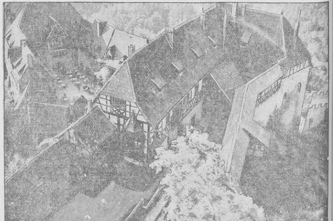
Blick auf die Wartburg, die historische Lutherfestung, die von dem Architekten Prof. Edoard Ehard unter Beibehaltung der bisherigen Umrisse durchgreifend renoviert wurde.
