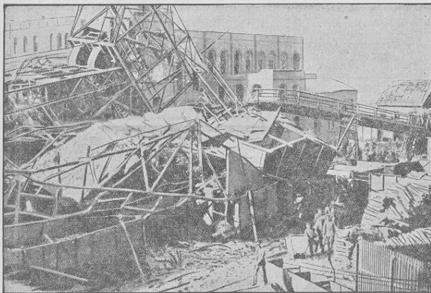
Unter diesen Trümmern liegen noch immer die Toten.
