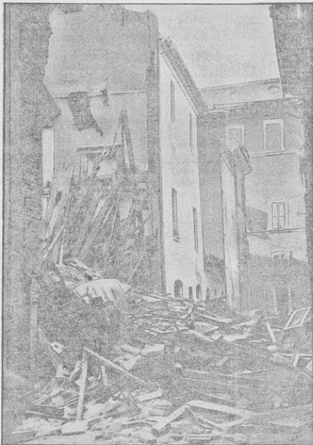
Eingestürztes Wohnhaus in Serravallo, einer Stadt von 25 000 Einwohnern, die fast völlig zerstört wurde. Mehrere Menschen fanden unter den Trümmern des Hauses den Tod.
