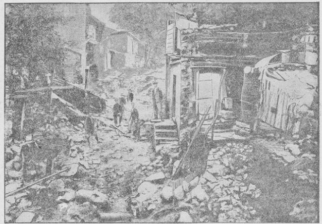
Häuser in Smyrna, die von einer Felslawine zerstört wurden.
