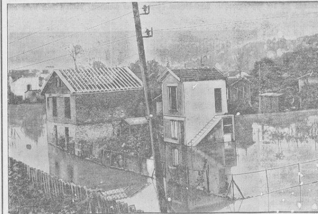
Die Steine und ihre Nebenflüsse führen Hochwasser, sind an zahlreichen Stellen, über die Ufer getreten und haben die Driftschiffen am Paris teils völlig überflutet.
