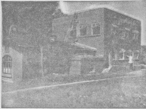
Das Wattforschungsanstalt am Hafen.
