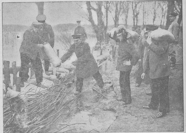
Die Berliner Feuerwehr arbeitet angestrengt, um die kleine Havelinsel Lindwerder bei Berlin-Gatow, die von den Ueberschwemmungen schwer betroffen wurde, durch Errichtung eines Staudammes zu schützen.
