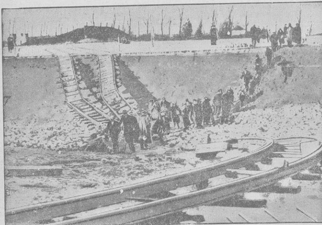
Die völlig verbogenen Eisenbahngleise der Strecke Antwerpen—St. Nicolas. Der Eisenbahnverkehr mußte stillgelegt werden.
