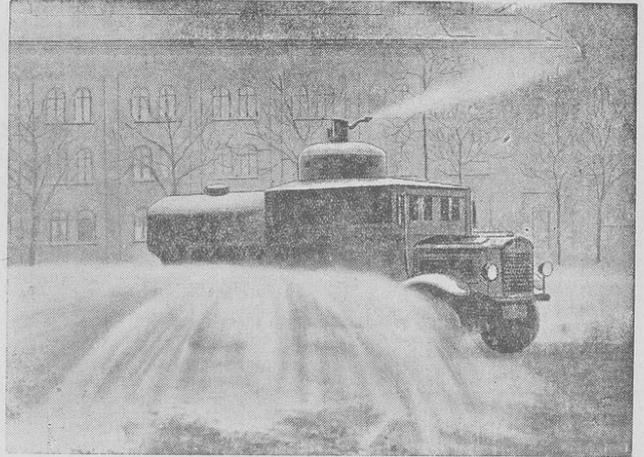
(Der gepanzerte Sprengwagen der Berliner Schutzpolizei in Betrieb.) Der Wagen schleudert einen Wasserstrahl mit zwölf Atmosphären Druck bis 40 Meter weit, — ein ebenso sicheres wie harmloses Mittel, um Krawall-Demonstrationen und Verammlungen auf den Straßen zu „sprengen“.
