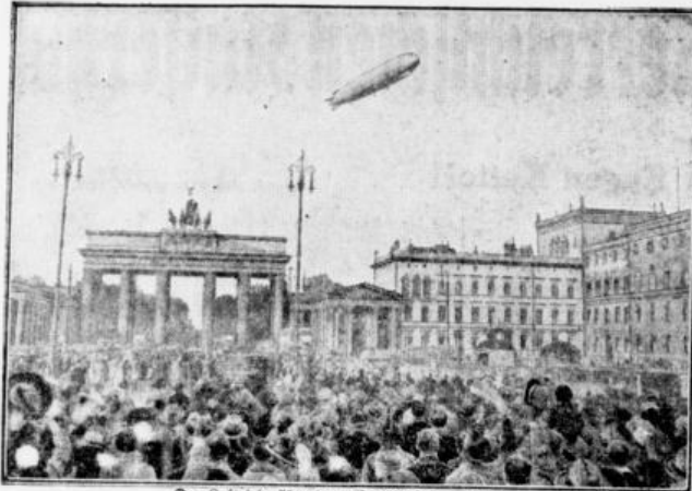
Der Luftsturm über dem Brandenburger Tor.
