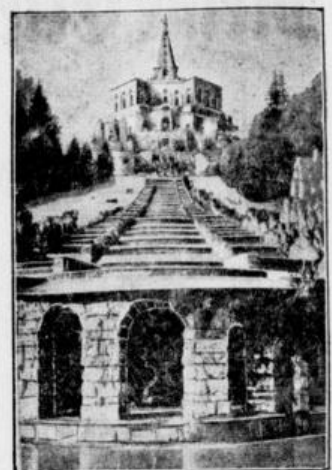
Einsturzgefahr für das Herkules-Denkmal in Wilhelmshöhe.
