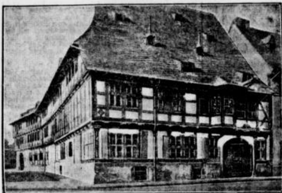
Das Siemens-Stammhaus in Goslar.
