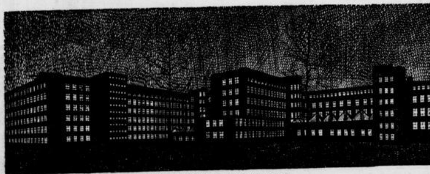
ABENDBILD UNSERER FABRIK IN WANDERSIEK
